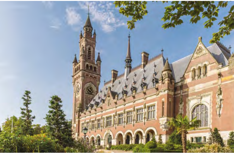
Vue extérieure du Palais de la Paix.
